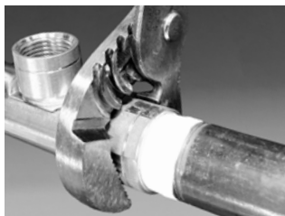
Figure 4.3 Soutien approprié du collecteur lors de l'installation des raccords
